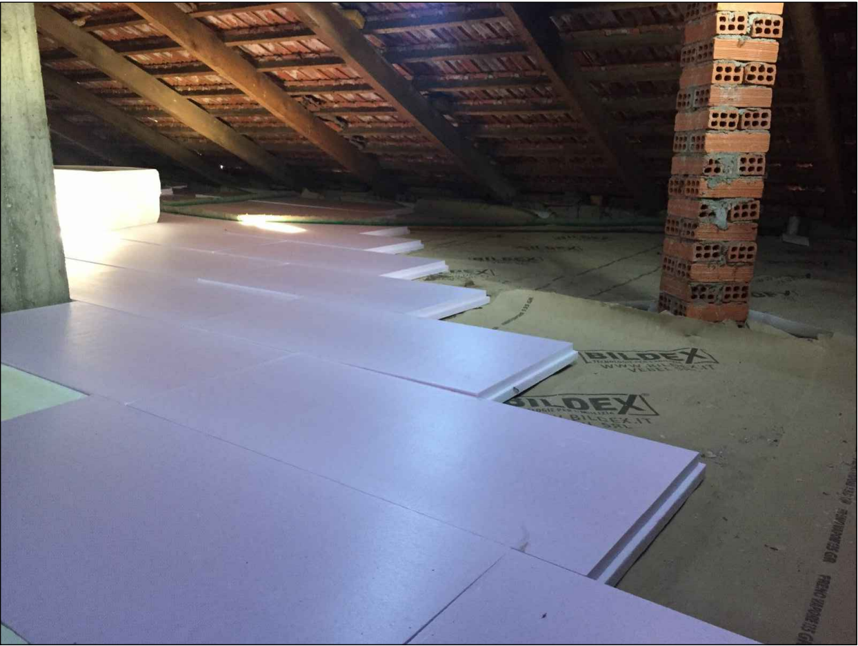
IMMAGINE TIPO DELL'APPLICAZIONE DELL'ISOLAMENTO TERMICO SUL SOLAIO SU SOTTOTETTO
